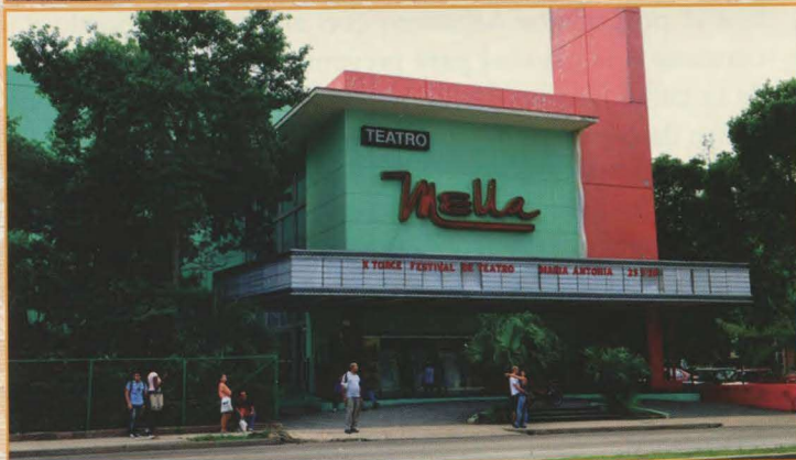
Cine Rodi, Línea y A, Vedado, 1.887 butacas Cine Rodi, actualmente llamado Mella Cine Rodi, Línea and A Streets, Vedado, 1,887 seats Cine Rodi is currently called Mella
